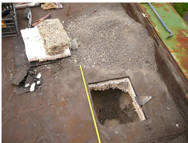
Sonda do střešní konstrukce.
