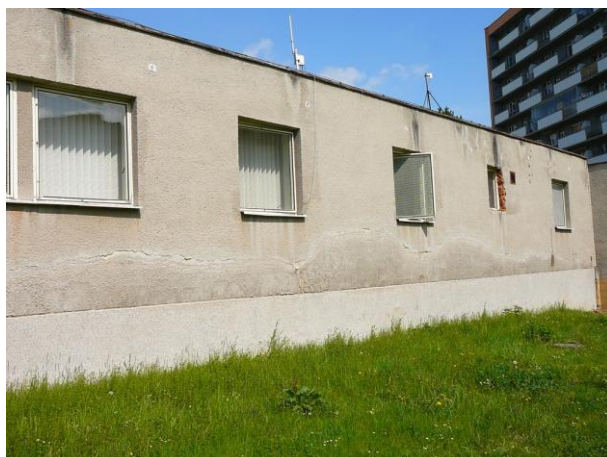
Pokračující část jižní strany s výraznými mapami vztlínající vlhkosti.
