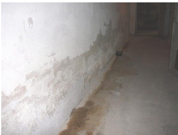
Situace v 1.PP, pohled na zeď, která je vzhledem k objektu vnitřní, ale tvoří obvodovou zeď sklepa. Vztlínání do výšky 60 cm.
