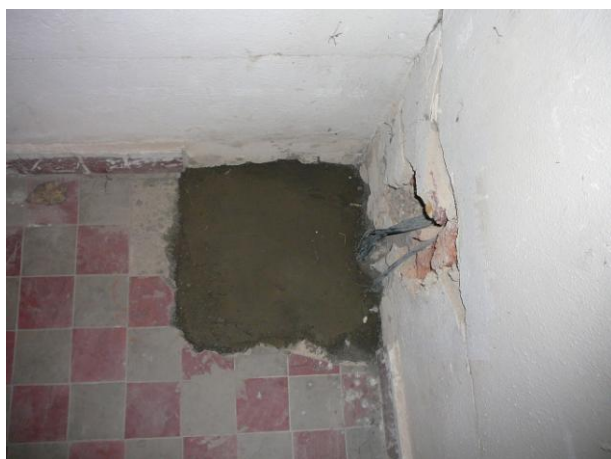
Zapravená sonda do podlahy.
