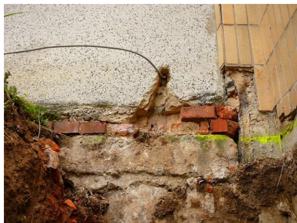
Detail pokračujícího betonového základu a nadzemního zdiva z cihel plných.
