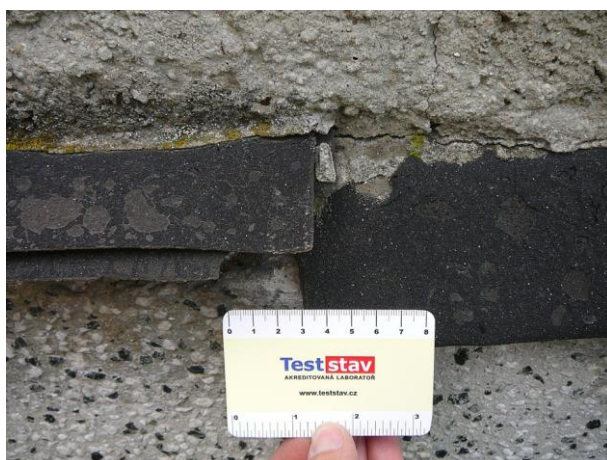
Detail překrytí jednotlivých pracovních záběrů předchozího dodatečného izolování.
