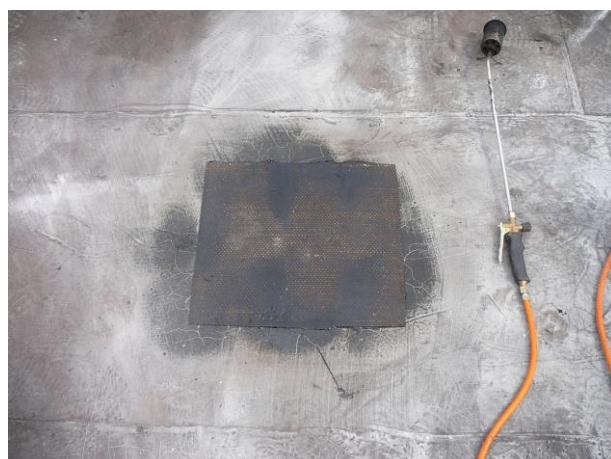
Sonda po zapravení a přeplátování novým asfaltovým pásem
