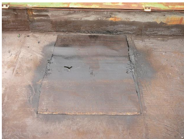
Sonda po zapravení.
