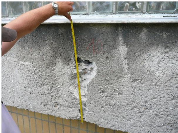
Situace na severní straně, parapetní zdivo je z pórobetonových tvárníc.
