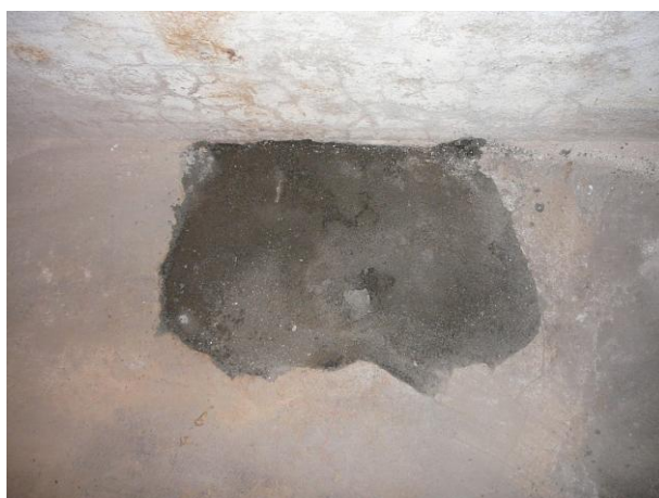
Zapravená sonda v 1.PP.
