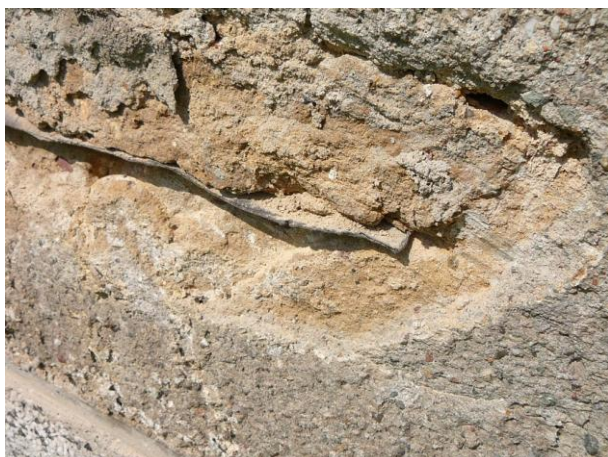
Ukončení dodatečně provedené vodorovné izolace.
