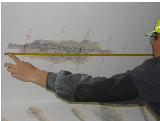
Měření vzdálenosti nosné výztuže desky.
