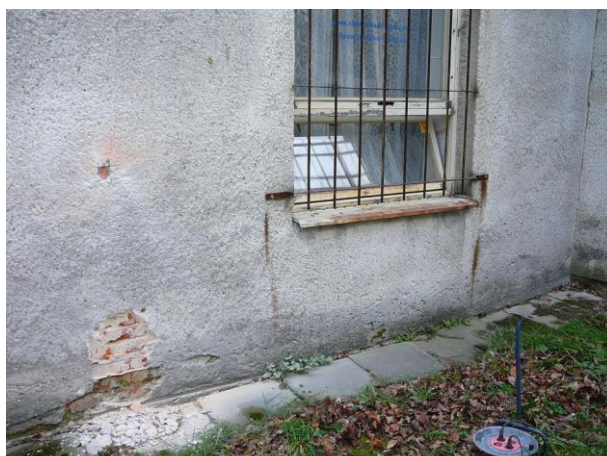
Vlevo dole je vidět dodatečně provedenou vodorovnou izolaci.
