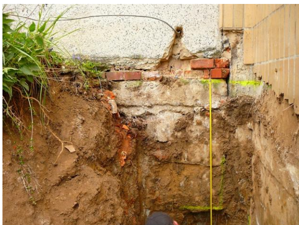
Odhalené základy z kamenných kvádrů v sondě na jižní straně objektu.
