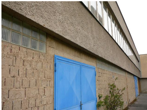
Spodní dozděná část z pálených cihel.
