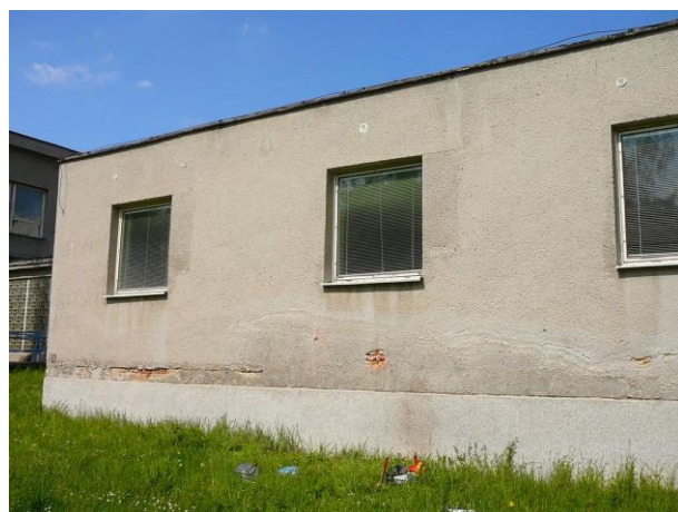
Část jižní strany objektu, kde je vidět v levé části fotky ukončenou izolaci a za ní zvýšenou úroveň zavlhnutí.
