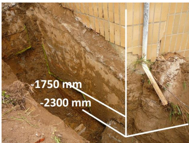
Sonda provedená ze západní strany.
