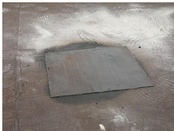
Zapravená sonda nad strojovnou.
