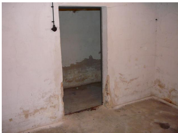
Vnitřní příčka, zde dochází ke korozi spodní části ocelových zárubní.
