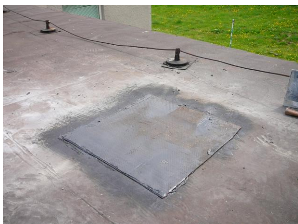
Zapravená sonda na střeše.
