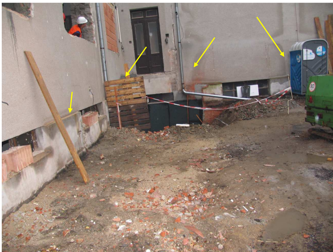
27 Míra zavlhčení dvorních obvodových stěn v úrovni podlahy 1.NP je opravdu vysoká
