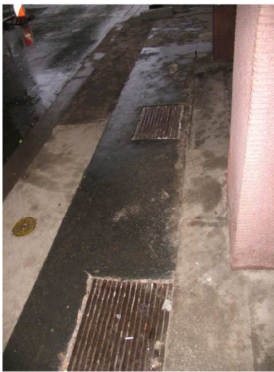
29,30 Hromadění srážkových vod je zdrojem průniku vlhkosti do substrukcí podlah v 1.NP
