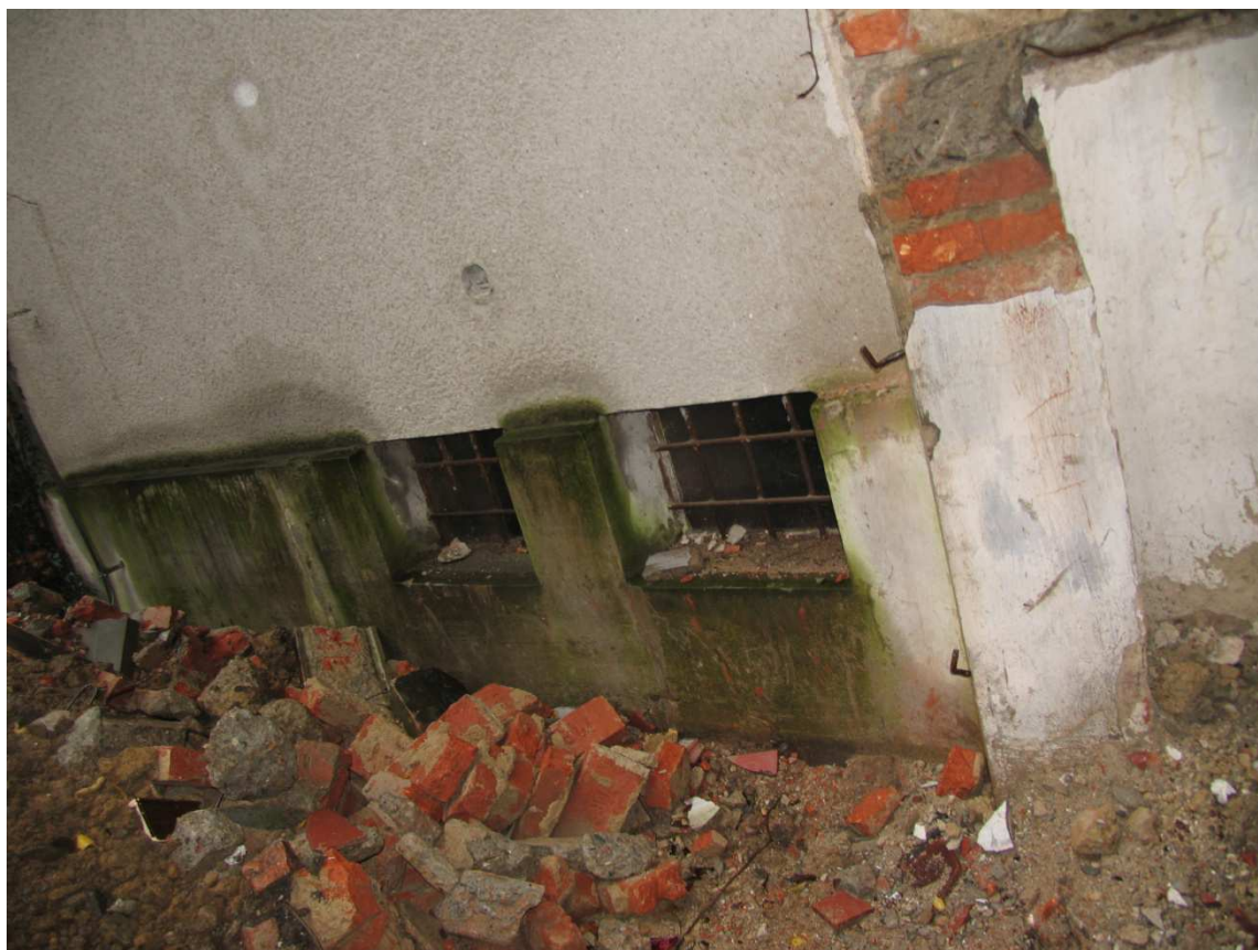
25 Zatékání do horního líce soklu zvyšuje vlhkost podlah v 1.NP
