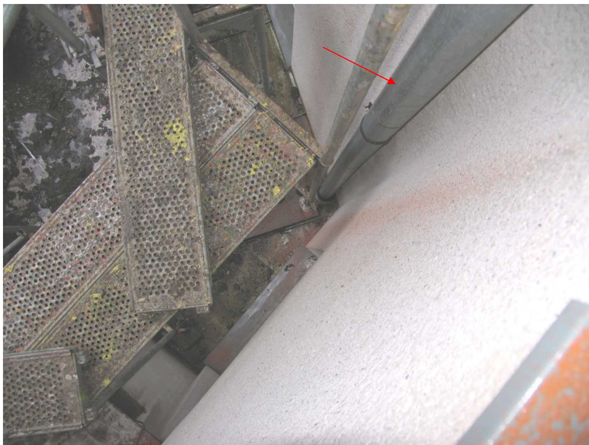
20 Přetékající dešťový svod zamokřuje fasádu a obvodové zdivo na rohu chodby
