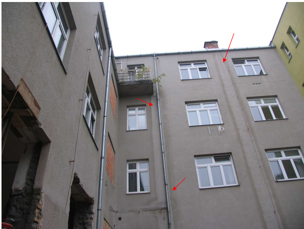
22, 23 Zatékání kolem dešťového svodu a po fasádě
