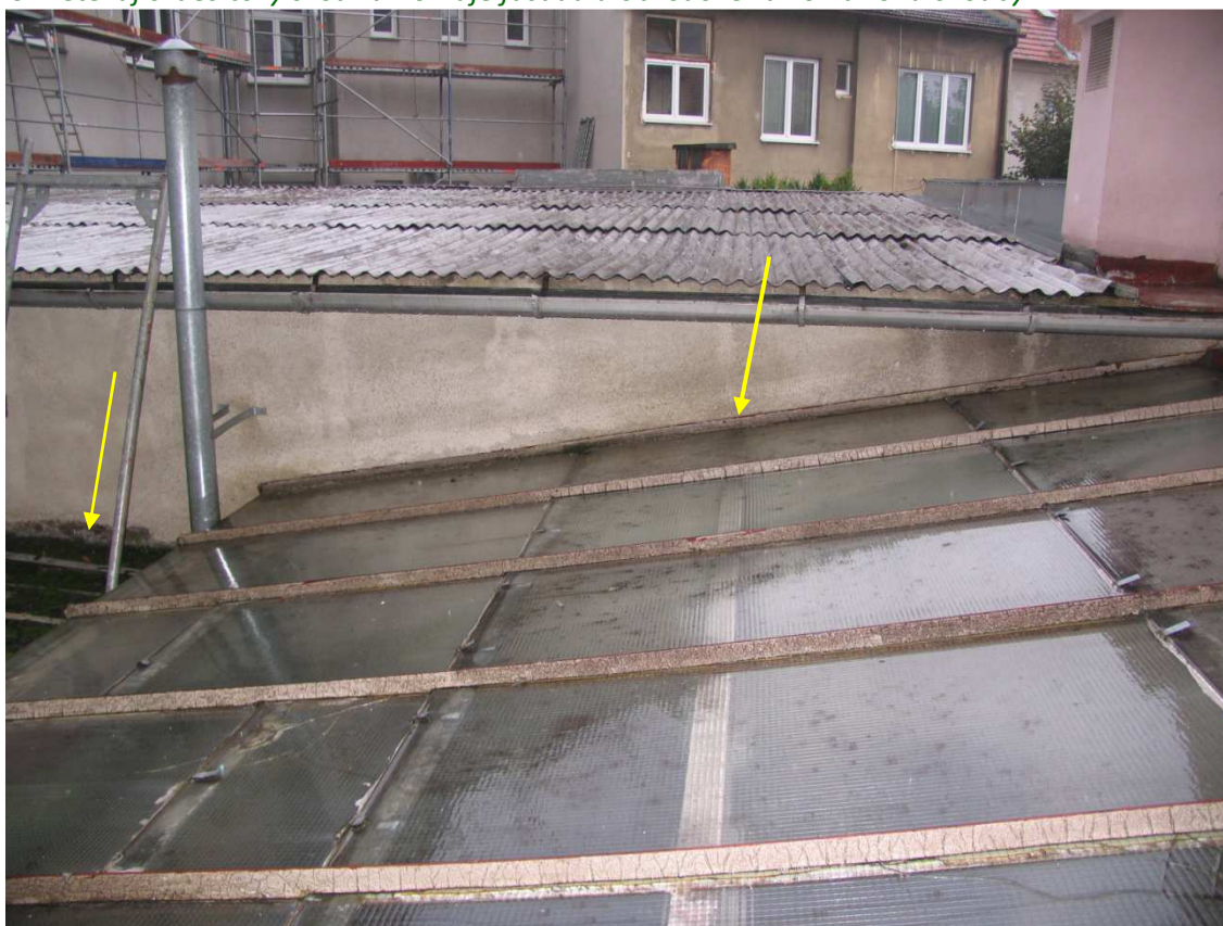
31 Zatékání střechou a oplechováním způsobuje zvyšování vlhkosti stěn v úrovni podlah ve 2.NP
