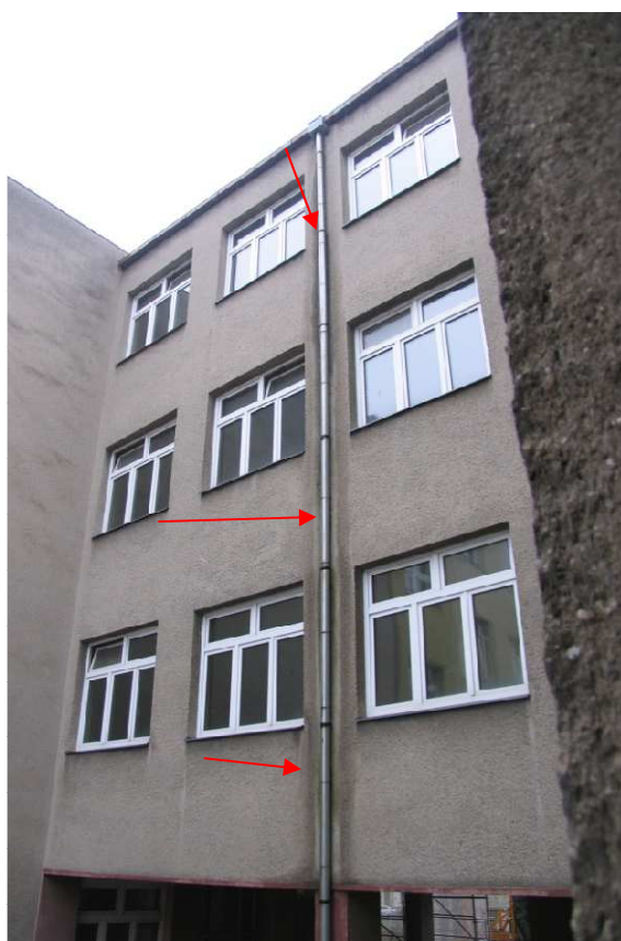
18,19 Zatékání do meziokenních pilířků kolem dešťového svodu v ose objektu
