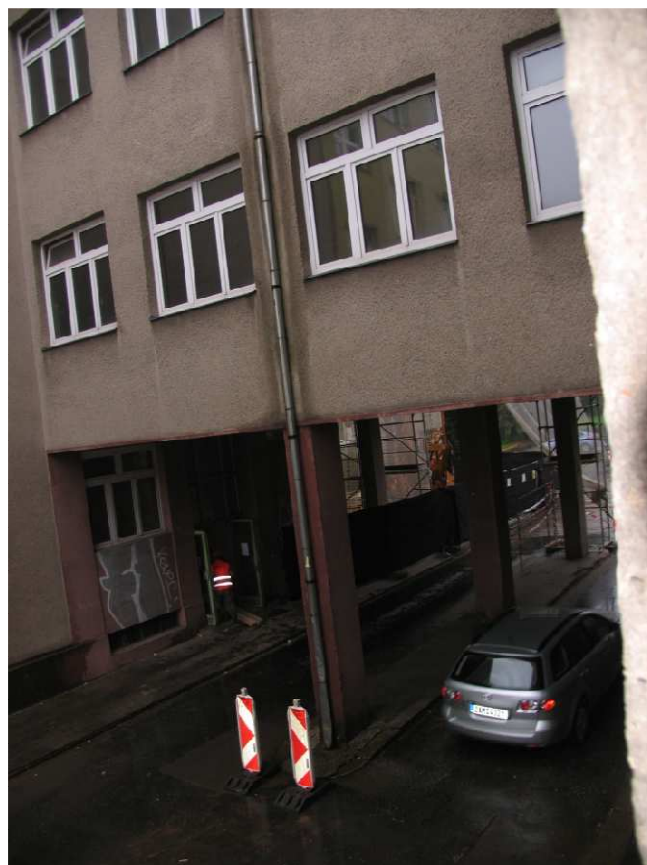
18,19 Zatékání do meziokenních pilířků kolem dešťového svodu v ose objektu
