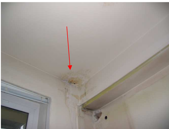
Na stropě 2.NP je vidět stopy této poruchy
