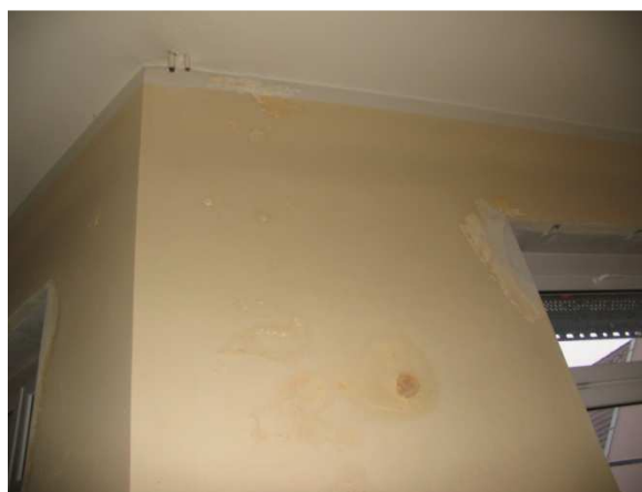
11,12 Místo odběru vzorku č. 2 na výskyt povrchových kolonií plísní na vlhkém zdivu v koutě chodby
