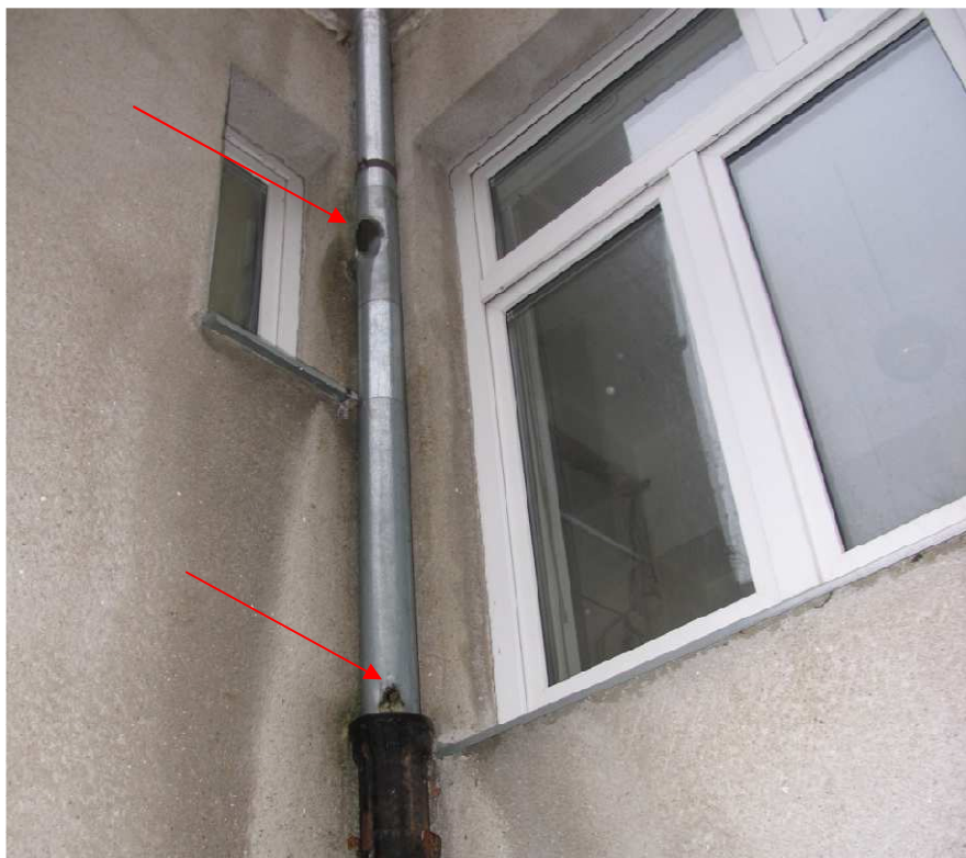
21 Proražený dešťový svod zamokřuje fasádu masivně
