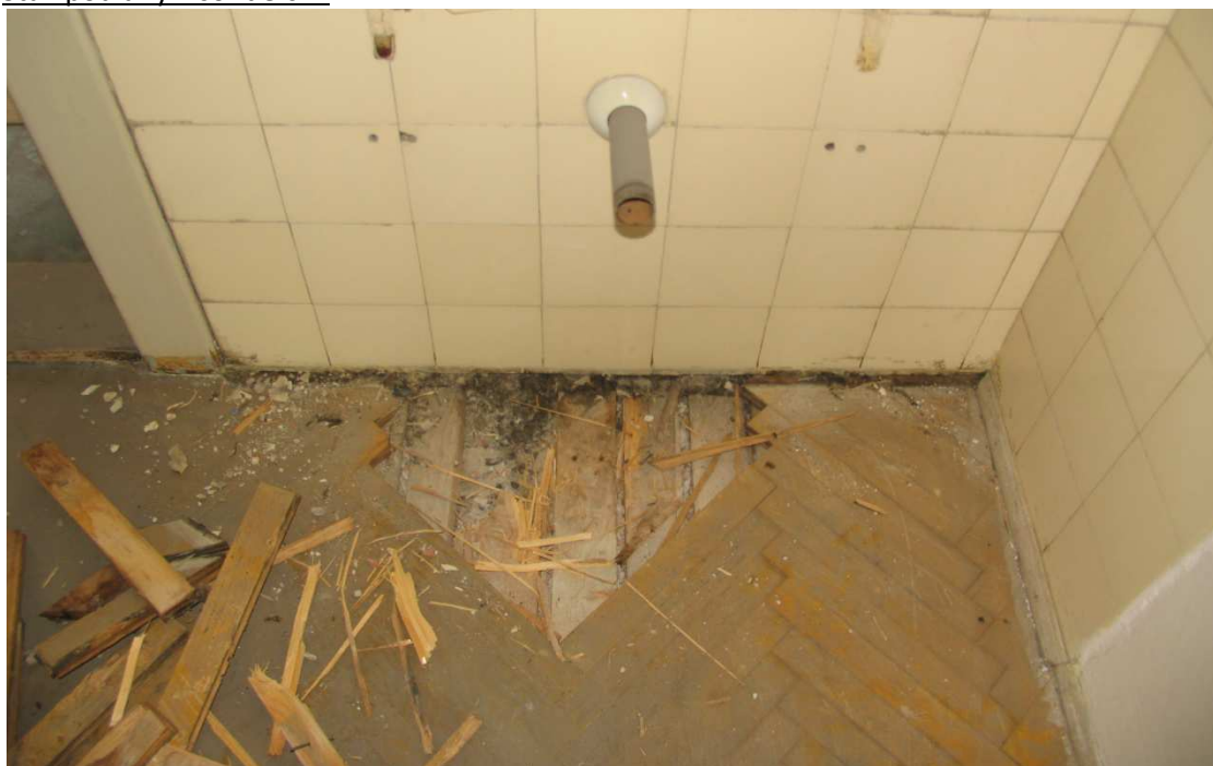
6 celkový pohled do sondy pod připojovacím odpadním potrubím pro umývadlo.
