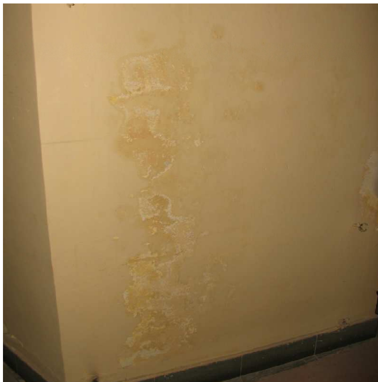
20 Vlhkost na stěně v místě zatékání dešťovým svodem je viditelná i na povrchu stěny
