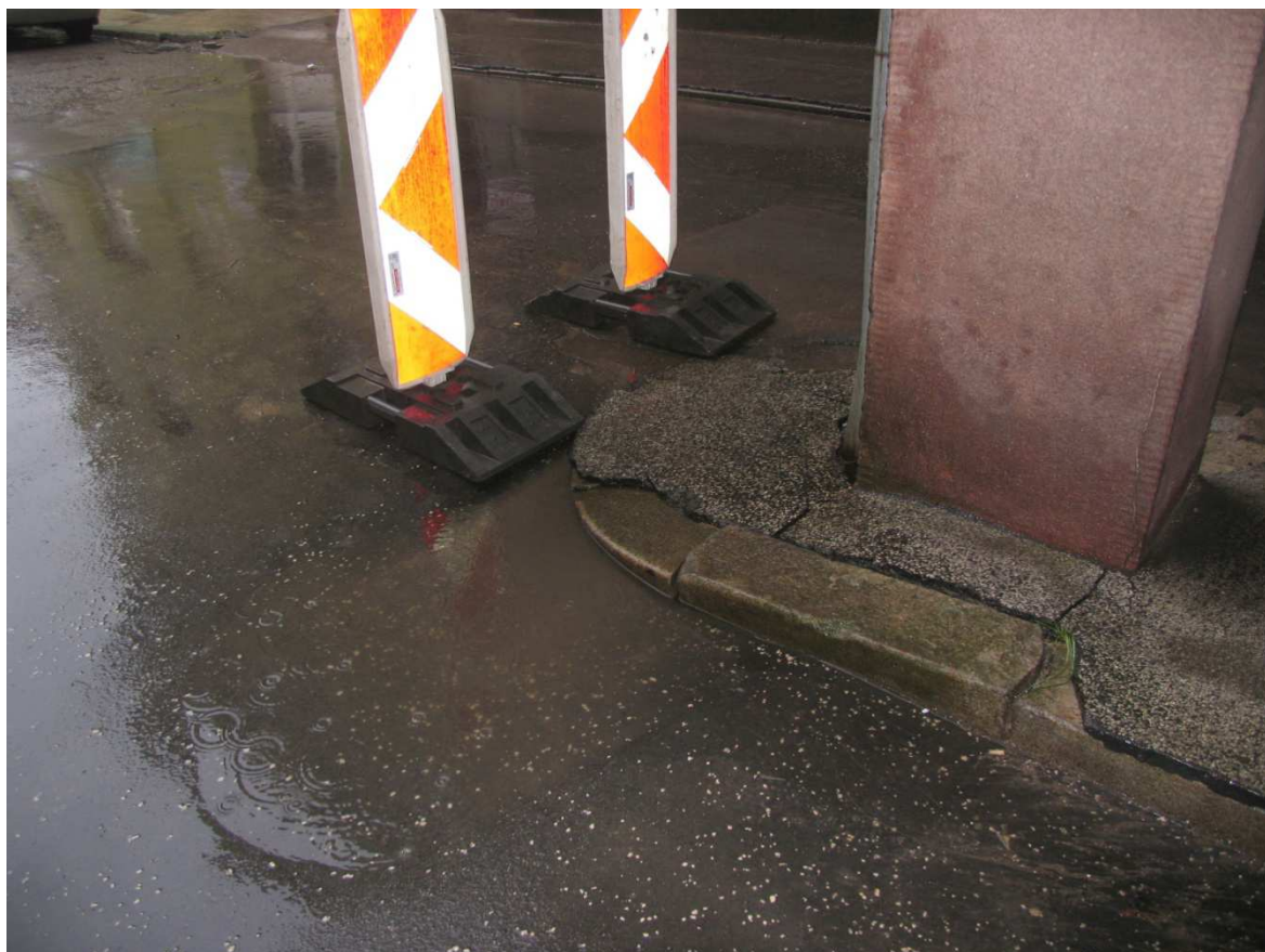
14 Hromadění srážkových vod v průjezdu
