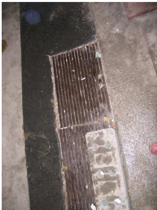
29,30 Hromadění srážkových vod je zdrojem průniku vlhkosti do substrukcí podlah v 1.NP
