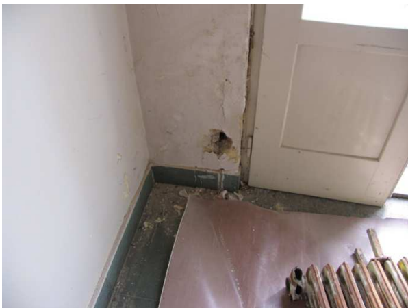
9. Poruchou izolace proniká do zdiva ostění v chodbě
