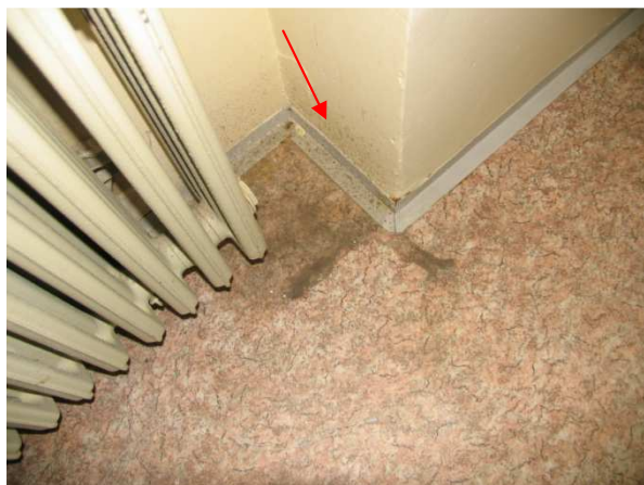
Kolonie plísní na povrchu zdiva v nise radiátoru
