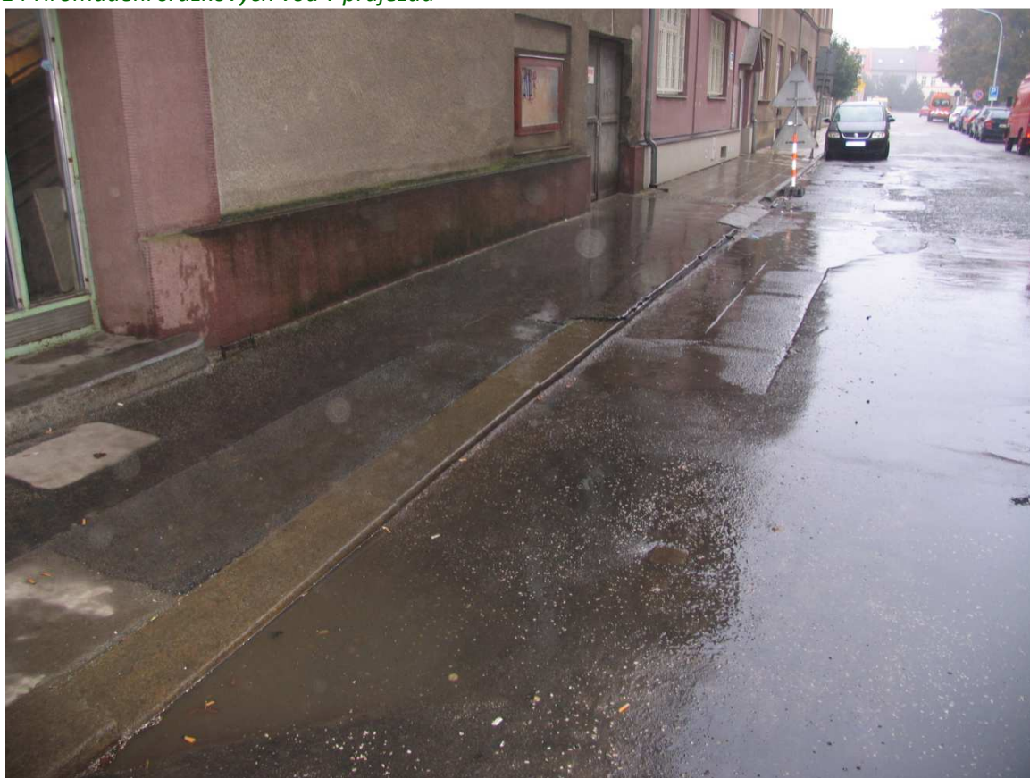
28 Ostřik stěn v úrovni soklu a hromadění dešťové vody u chodníku zavlhčuje stěny a podlahy 1.NP
