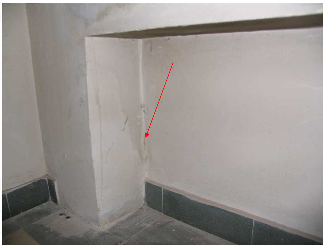
10 Místo s vysokou vlhkostí zdiva a kolonií plísní – odběr vzorku č. 1 na vnějším líci stěny
