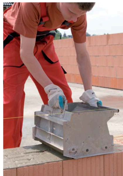
celoplošné nanášení vozíkem
