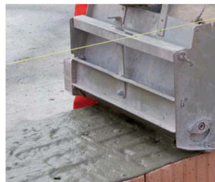
celoplošné nanášení vozíkem
