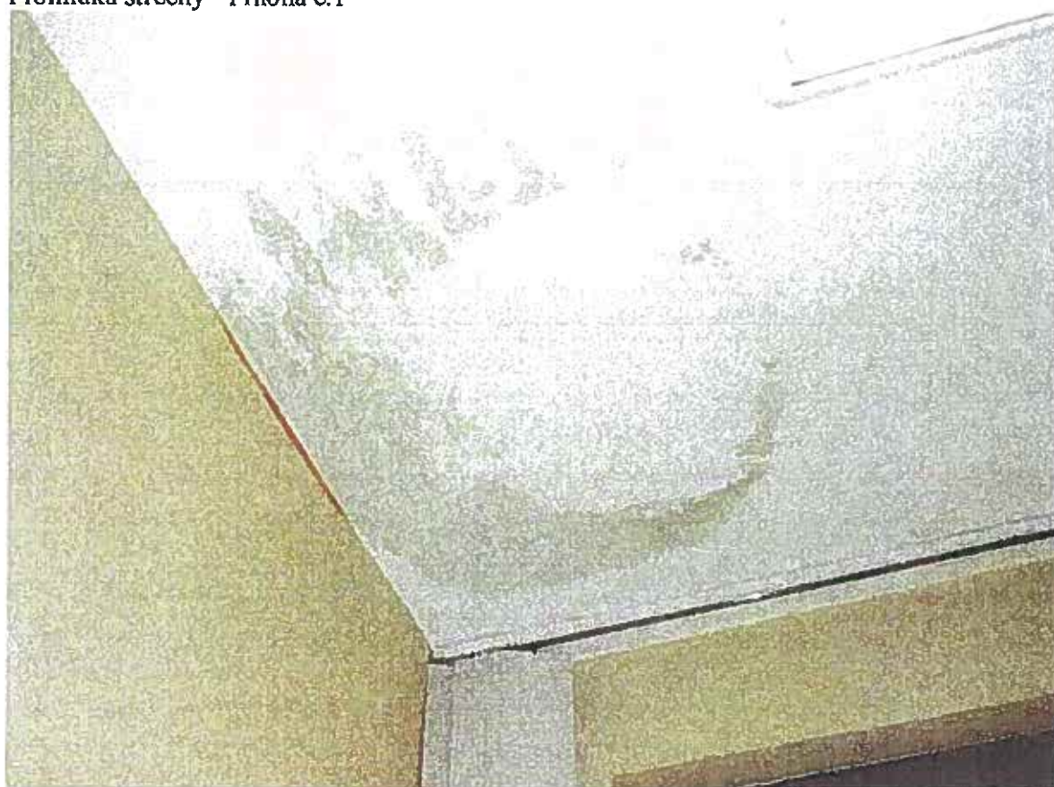
Prohlídka střechy - Příloha č.1
